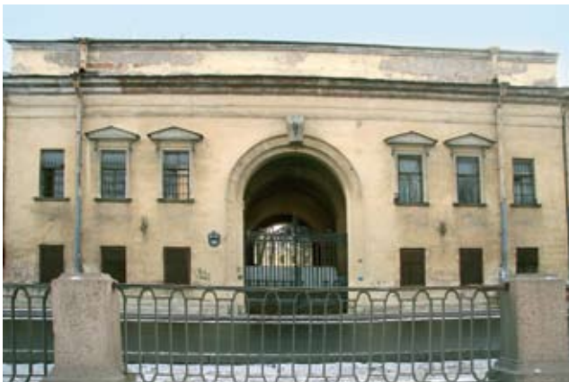
Первый корпус Калининской больницы с литыми воротами в здании бывшего Пряильного двора Петровского времени 1718 года
